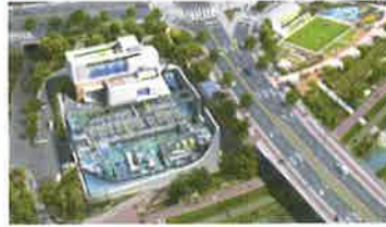
시흥목감 하수처리장 발주처 ----- 시흥시 용 량 ----- 13,000m 3 /day
